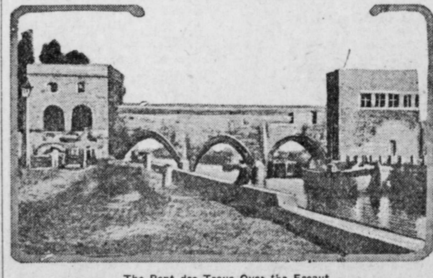
The Pont des Troues Over the Escaut.
