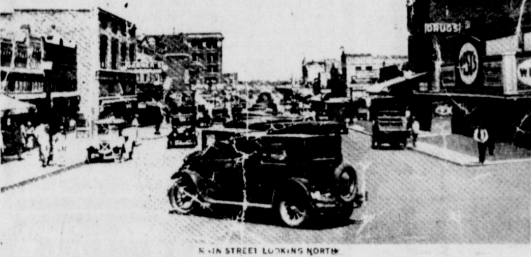
N. N. STREET LOOKING NORTH
